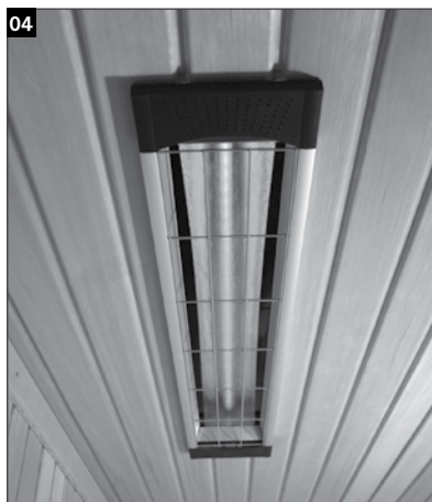
Einbau eines 1300 Watt Strahlers in die Decke.
