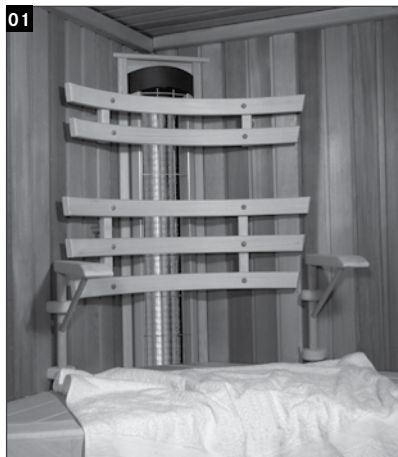
Einbau eines 500 Watt Strahlers in die Ecke der Sauna mit Rücken- und armlehne.
