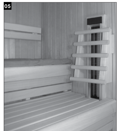
Einbau eines 500 Watt Strahlers mit einer Holzverkleidung auf der 2. Stufe der Sauna.
