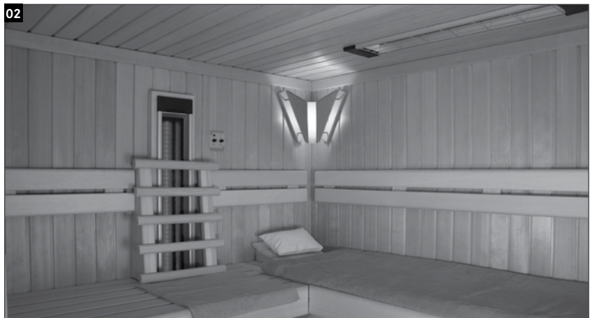
Einbau eines 500 Watt Strahlers in die Seitenwand mit Holzverkleidung (links) und eines 1300 Watt Strahlers an der Decke (rechts oben).
