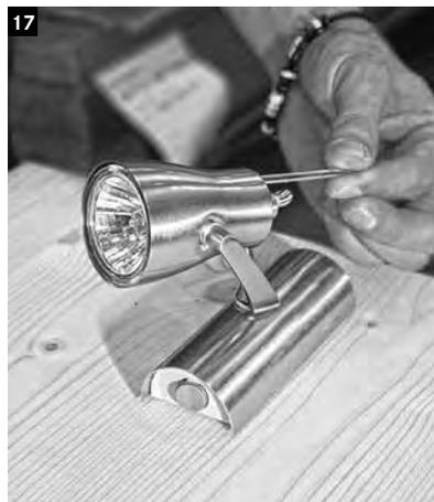
17 Die Innenbeleuchtung an der Rückwand montieren. Die Elektroanschlussarbeiten von einem autorisierten Elektrounternehmen vornehmen lassen. Dazu wird die Anschlussleitung mit Stecker und freiem Ende (100 cm) benötigt.
