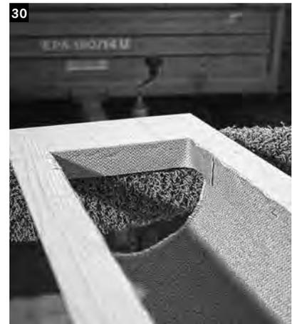
Das lange Stück des Brandschutzbandes am unteren Ende des Strahlerpaneels befestigen.
