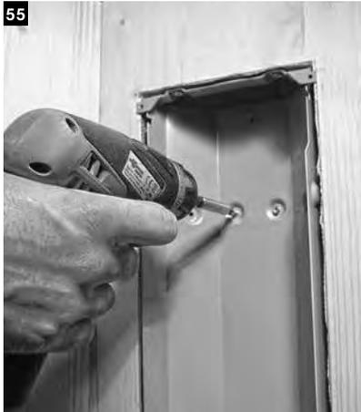
55 Durch die an der Rückwand des Einbaugeschüsses vorgesehenen Ausbeulungen das Strahlerpaneel an der Infrarotkabine festschrauben. Dafür die Schrauben leicht schräg einschrauben.
