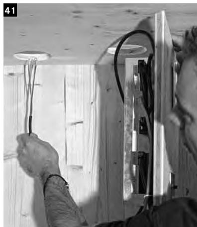
41 Das Bedienungspaneel in die Infrarotkabine stellen (Leistungsteil oben) und die Anschlussleitung mit den isolierten Flachsteckhülsen durch den linken hinteren Ausschnitt geben – bei Farblicht auch die Buchse der Verlängerungsleitung.
