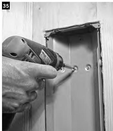
Durch die an der Rückwand des Einbaugeschützes vorgesehenen Ausbeulungen das Strahlerpaneel an der Infrarotkabine festschrauben. Dafür die Schrauben leicht schräg einschrauben.
