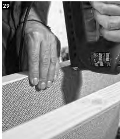
Die lange Seite des Strahlerauschnittes mit der großen Brandschutzmatte auskleiden.
