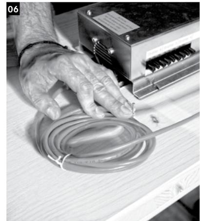
Fixieren Sie die Kabel mit Nagelschellen an der Rückseite der Infrarotkabine. Achten Sie dabei auf den Abstand zwischen Daten- und Stromleitung.
