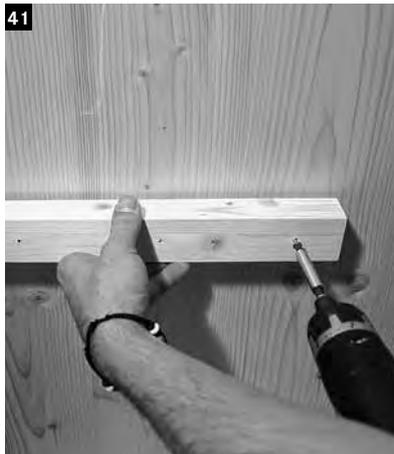
Sitzleiste an den Seitenwänden festschrauben.
