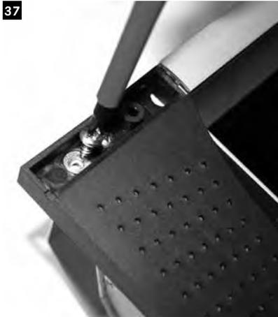
37 Dafür die äußersten Schrauben an den Ecken des Strahlers herauschrauben und den Strahler vorsichtig vom Einbaugehäuse lösen.
