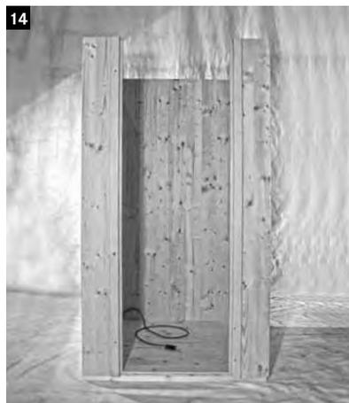
Die Teile der Vorderwand können kopfüber gedreht werden und so links oder rechts montiert werden.
