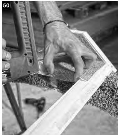
Die Oberseite des Strahlerausschnittes mit dem Ende der eingeschnittenen Brandschutzmatte auskleiden.
