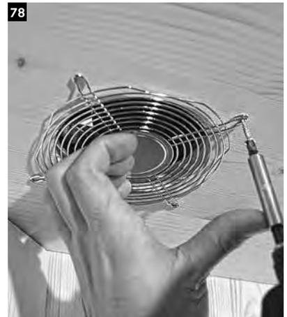
78 Im Inneren der Infrarotkabine das Lüftungsgitter über den Ausschnitt des Ventilators am Deckenpaneel befestigen.
