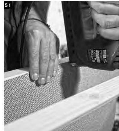
Die lange Seite des Strahlerausschnittes mit der großen Brandschutzmatte auskleiden.
