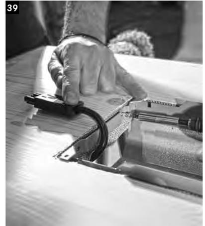
39 An der Unterseite die Buchse für den Anschluss des Strahlers durch die Öffnung des Einbaugehäuses geben.
