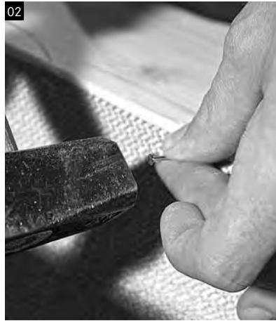
Den Ausschnitt, in dem später der Strahler montiert wird, mit der Brandschutzmatte längsseitig mit Hilfe der mitgelieferten Nägel auskleiden.
