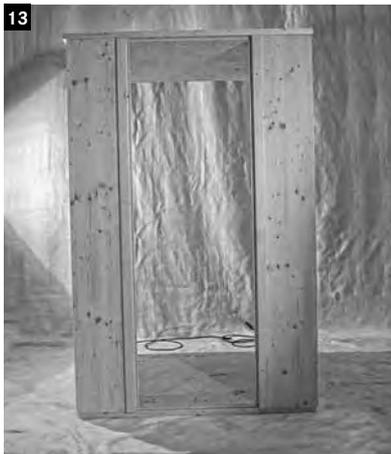
13 Nun das Deckenpaneel mit Hilfe einer zweiten Person auf die Infrarotkabine legen.
