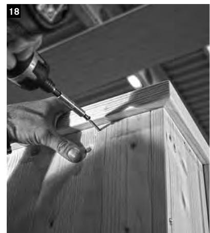
Das Deckenpaneel mit den Seitenwänden an den vorgebohrten Stellen verschrauben.
