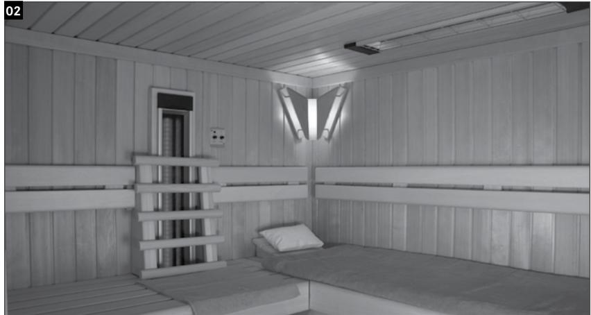
Einbau eines 500 Watt Strahlers in die Seitenwand mit Holzverkleidung (links) und eines 1300 Watt Strahlers an der Decke (rechts oben).
