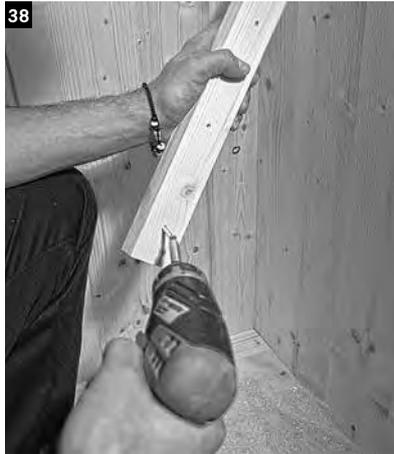
Für die Montage der Sitzbank die Schrauben durch die Vorbohrungen der Sitzbankleisten schrauben.
