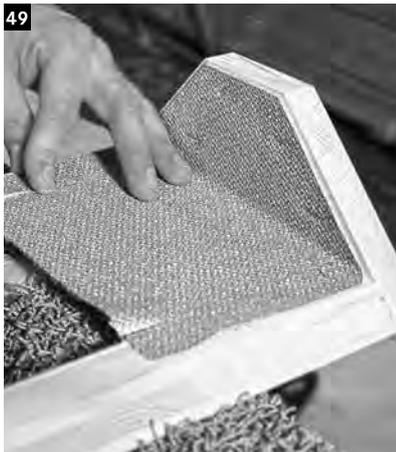
Dazu die passend zugeschnittene Brandschutzmatte am oberen Ende des Strahlerpaneels mit den mitgelieferten Nägeln oder einem Tacker befestigen.
