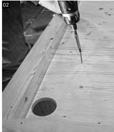
... und zusätzlich einen Ausschnitt für die Anschlussleitung schneiden (ca. Ø 4 cm). Durch diesen die Buchse der Verlängerungsleitung von der Decke in die Infrarotkabine geben und das Farblicht daran anstecken. Das Farblicht von unten an die Decke drücken und von oben festschrauben. (Siehe Anschlussbeschreibung auf Seite 59)
