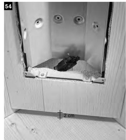
Das Strahlerpaneel am rechten vorderen Eck der Infrarotkabine positionieren. Und zwar so, dass zur Bodenplatte ca. 2 cm Abstand sind.
