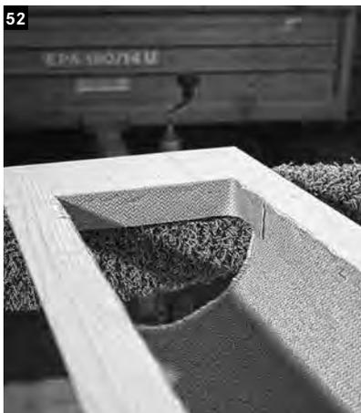
Das lange Stück des Brandschutzbandes am unteren Ende des Strahlerpaneels befestigen.
