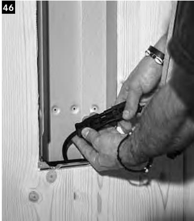
Für die Montage des Tiefenwärmestrahlers im Bedienungspaneel den 500 Watt Strahler (ohne Berührungsschutz-Gitter) zur Hand nehmen und die Buchse der Anschlussleitung, die durch das Einbaugehäuse geht, mit dem Stecker des Strahlers verbinden. Den Strahler vorsichtig in das Einbaugehäuse setzen.
