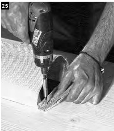
Bedienungspaneel umdrehen und auf der oberen Seite des Strahlerauschnittes den Hitzeschutz festschrauben.
