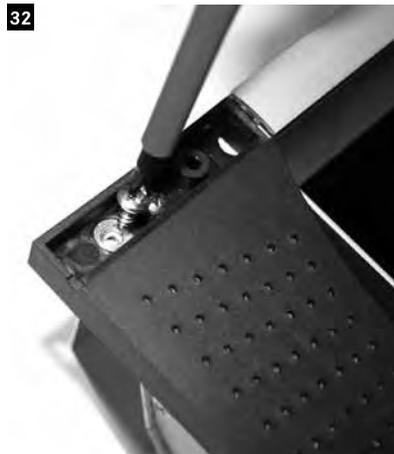
Dafür die äußersten Schrauben an den Ecken des Strahlers herausschrauben und den Strahler vorsichtig vom Einbaugeschütz lösen.
