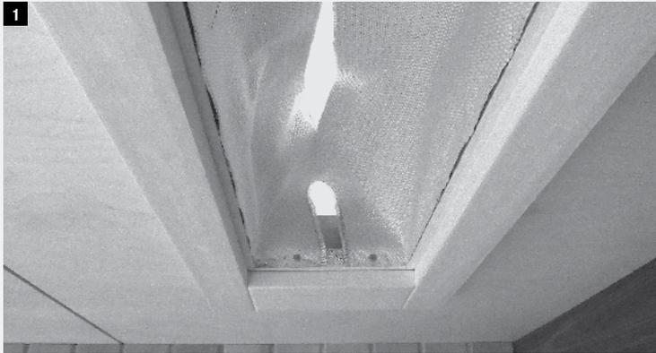
Die Leibung mit dem Brandschutz wie am Bild abgebildet auskleiden. Bei der Montage in der Decke wird die Brandschutzmatte zur Belüftung mittig aufgeschnitten (siehe Beispiel 3 auf Seite 73). Danach den Einbaurahmen im Holzausschnitt entsprechend festschrauben.
