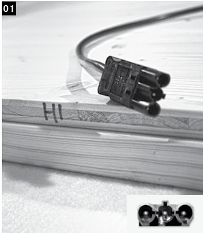
Achten Sie bei der Verkabelung der Infrarotkabine darauf, dass der **STECKER** der Verkabelung zur Steuerung geführt wird.
