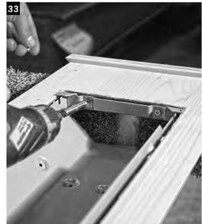
Das Einbaugeschütz in die mit dem Brandschutz ausgekleideten Ausschnitte (Strahlerpaneele und Rückwand) positionieren und an der Ober- und Unterseite festschrauben.
