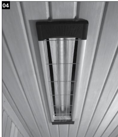
Einbau eines 1300 Watt Strahlers in die Decke.
