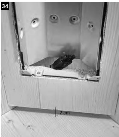
Das Strahlerpaneel am rechten und linken vorderen Eck der Infrarotkabine positionieren. Und zwar so, dass zur Bodenplatte ca. 2 cm Abstand sind.
