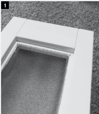
Versehen Sie den gesamten Ausschnitt des Einbaurahmens mit der Brandschutzmatte. Auch die Rundung nach oben hin.
