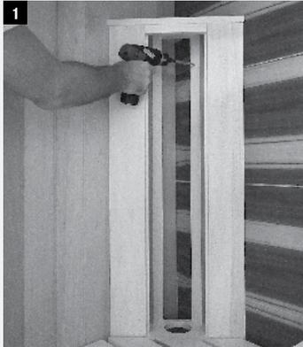
Befestigen Sie die Eckverblendung in das entsprechende Eck der Sauna. Das Loch für die Stromversorgung muss unten sein.
