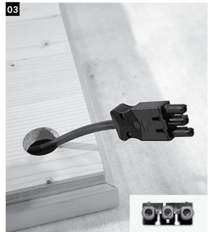
Die Buchse kommt durch den vorderen runden Ausschnitt. Daran wird später der Infrarotstrahler angeschlossen.
