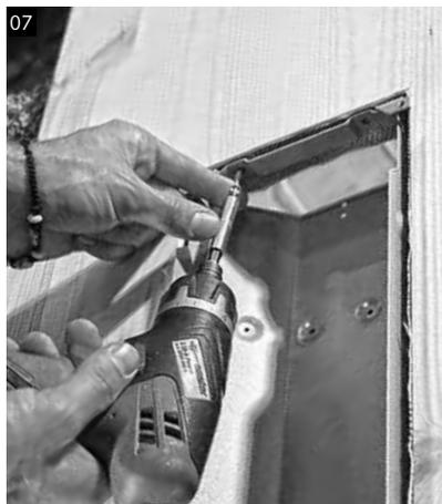
Das Einbaugeschäse in den mit dem Brandschutz ausgekleideten Ausschnitt positionieren und an der Ober- und Unterseite festschrauben.
