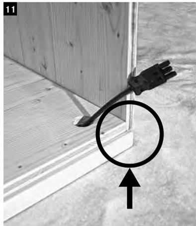
Die Seitenwand muss hinten und vorne mit der Bodenplatte bündig sein.
