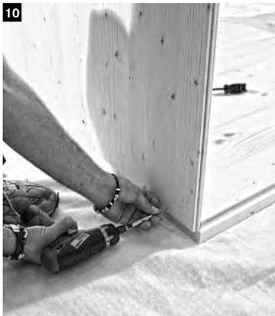
Die linke Seitenwand und die Rückwand auch an der Unterseite mit der Bodenplatte verschrauben.
