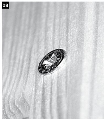
Alle Schrauben im Sichtbereich werden später mit Abdeckkappen abgedeckt. Daher nicht ganz in das Holz versenken!
