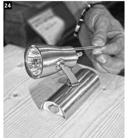
Die Innenbeleuchtung montieren. Die Elektroanschlussarbeiten von einem autorisierten Elektro- unternehmen vornehmen lassen. Dazu wird die Anschlussleitung mit Stecker und freiem Ende (100 cm) benötigt.
