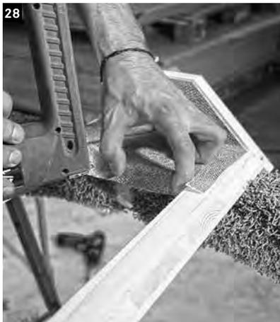
Die Oberseite des Strahlerauschnittes mit dem Ende der eingeschnittenen Brandschutzmatte auskleiden.
