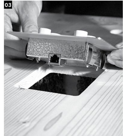
Vom **Innenraum** der Infrarotkabine wird das Steuerungsbedienteil in den vorgesehenen Ausschnitt in der Rückwand gedrückt.
