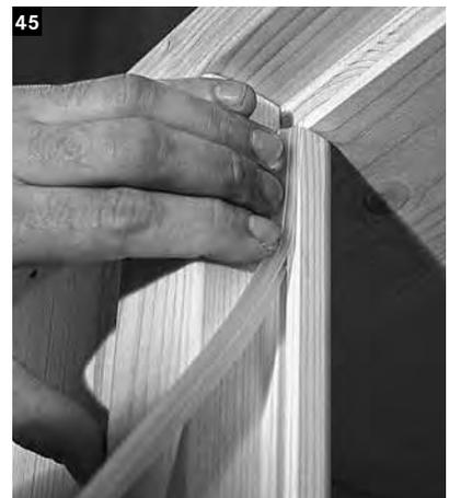
Die Türdichtung in die Einkerbungen beider Vorderwand-Teile drücken.
