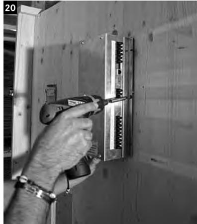
20 Das Leistungsteil auf der Rückseite der Infrarotkabine unterhalb der Innenbeleuchtung in der vertikalen Mitte anschrauben.
