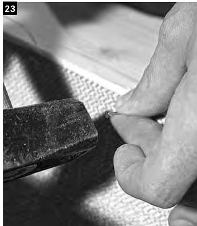
23 Die Strahlerauschnitte in der Rückwand mit dem Brandschutz versehen. Dafür wird an den Leibungen, in die später die Strahler montiert werden, längsseitig die Brandschutzmatte mit Hilfe der mitgelieferten Nägel ausgekleidet.
