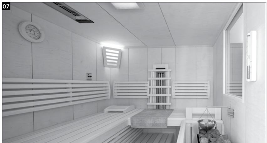
Bündiger Einbau eines 1300 Watt Strahlers in die Decke und Einbau eines 500 Watt Strahlers in die Sauna Wand.
