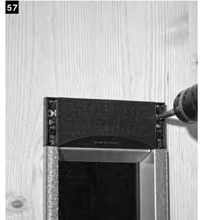
57 Den Strahler positionieren und wieder mit den zuvor gelösten, äußeren Schrauben am Einbaugeschüss befestigen. Die Schrauben mit den mitgelieferten Abdeckkappen abdecken.
