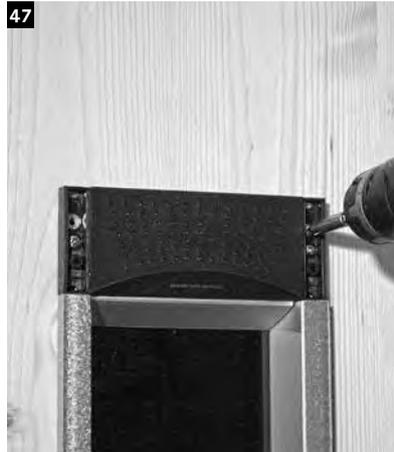
Den Strahler positionieren und wieder mit den zuvor gelösten, äußeren Schrauben am Einbaugehäuse befestigen. Die Schrauben mit den mitgelieferten Abdeckkappen abdecken.
