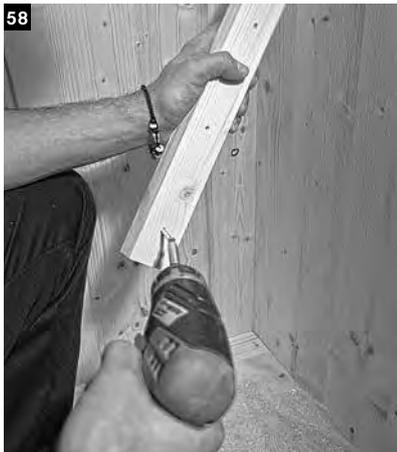
58 Für die Montage der Sitzbank die Schrauben durch die Vorbohrungen der Sitzbankleisten schrauben.
