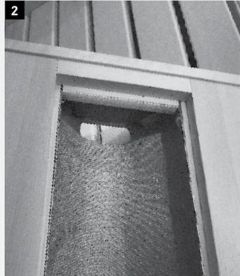
Versehen Sie den gesamten Ausschnitt des Einbaurahmens mit der Brandschutzmatte und schneiden Sie ein Lüftungloch aus.
