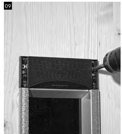
Den Strahler positionieren und wieder mit den zuvor gelösten, äußeren Schrauben am Einbaugeschäse befestigen. Die Schrauben mit den mitgelieferten Abdeckkappen abdecken.
