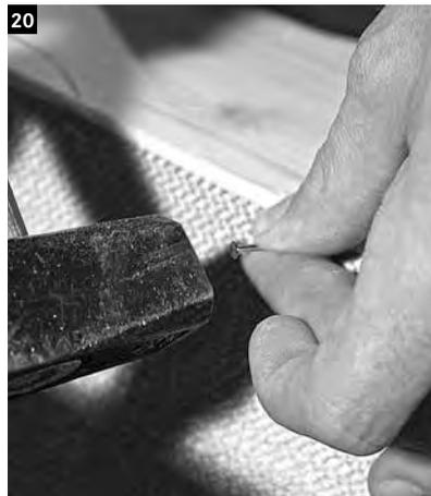
Beim Bedienungspaneel die Leibung, in die später der Strahler montiert wird, mit der Brandschutzmatte längsseitig mit Hilfe der mitgelieferten Nägel auskleiden.
