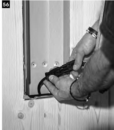
56 Für die Montage des Tiefwärmestrahlens im Strahlerpaneel den 750 Watt Strahler (mit Berührungsschutz-Gitter) zur Hand nehmen und die Buchse der Anschlussleitung durch das Einbaugeschüss ziehen und mit dem Stecker des Strahlers verbinden. Den Strahler vorsichtig in das Einbaugeschüss setzen.
