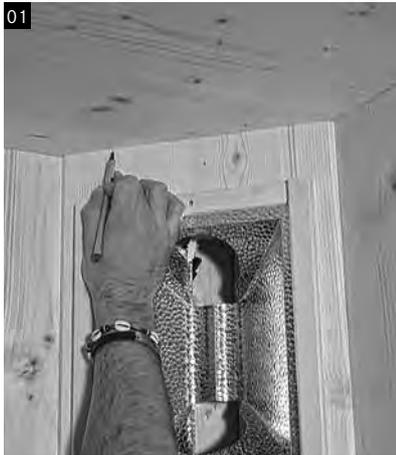
Für die Montage des Thera-Med® Farblicht-Systems das Farblicht in der rechten hinteren Ecke der Infrarotkabine positionieren. Mit einem Bleistift einen Strich an der Vorderkante machen. Ca. 1 cm Richtung Ecke rücken und dort der Länge nach zweimal in die Decke vorbohren ...
