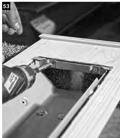
Danach wie schon beim Bedienungspaneel das Einbaugehäuse des Strahlers im Ausschnitt montieren.
