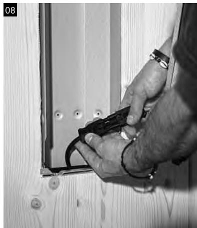
Den Tiefenwärmestrahlers zur Hand nehmen und die Buchse der Anschlussleitung, die durch das Einbaugeschäse geht, mit dem Stecker des Strahlers verbinden. Den Strahler vorsichtig in das Einbaugeschäse setzen.
