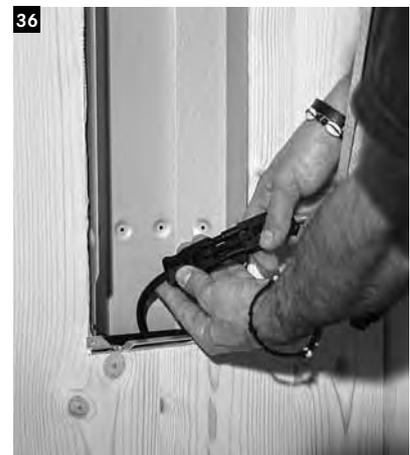
Nun den 750 Watt Strahler (mit Berührungsschutzgitter) zur Hand nehmen und die Buchse der Anschlussleitung durch das Einbaugeschütz ziehen und mit dem Stecker des Strahlers verbinden. Den Strahler vorsichtig in das Einbaugeschütz setzen.
