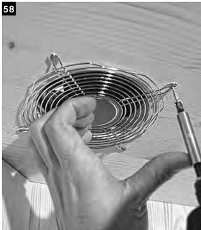
Im Inneren der Infrarotkabine das Lüftungsgitter über den Ausschnitt des Ventilators am Deckenpaneel befestigen.
