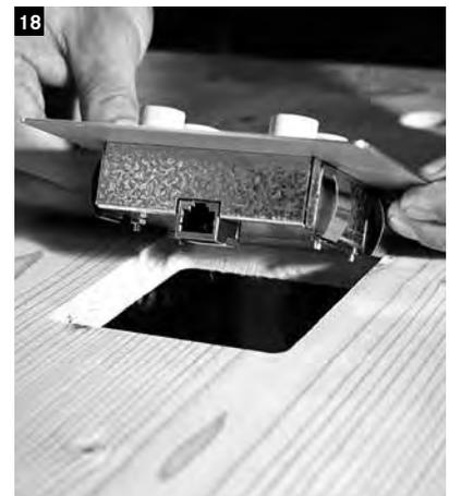
18 Vom Innenraum der Infrarotkabine nun das Steuerungsbedienteil in den vorgesehenen Ausschnitt in der Rückwand drücken.
