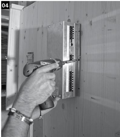
Das Leistungsteil wird auf der Rückseite der Infrarotkabine montiert. Achten Sie dabei auf die Montagehöhe der Steuerung (siehe Zeichnung links)
