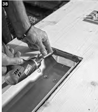
38 Das Einbaugehäuse in den mit dem Brandschutz ausgekleideten Ausschnitt positionieren und an der Ober- und Unterseite festschrauben.
