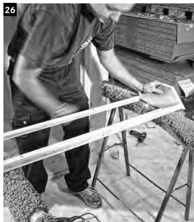
26 Als nächstes die Strahlerpaneele zur Hand nehmen und mit dem Brandschutz auskleiden.
