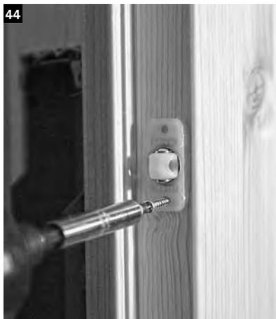
Für die Montage der Tür den Türschnapper in die Vorbohrung in der Vorderwand Teil 1 geben und festschrauben.
