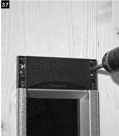
Den Strahler positionieren und wieder mit den zuvor gelösten, äußeren Schrauben am Einbaugeschäuse befestigen. Die Schrauben mit den mitgelieferten Abdeckkappen abdecken.
