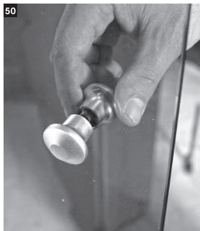
50 Den Türkopf montieren.
