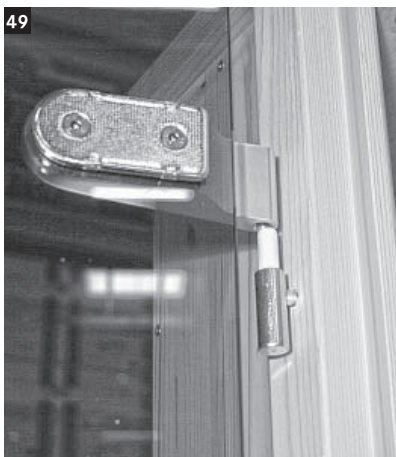
49 Die Glastüre einhängen und passend einstellen.
