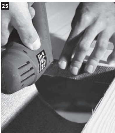
25 Die kurzen Brandschutzbänder an der kurzen Seite der Leibung anbringen.
