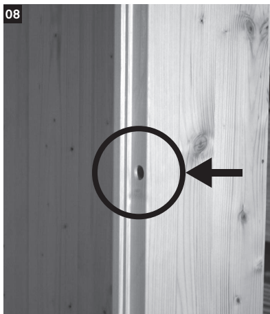
08 Vorderwand Teil 1 ist der Teil, wo der Türschnapper montiert wird und die Tür später geöffnet wird.
