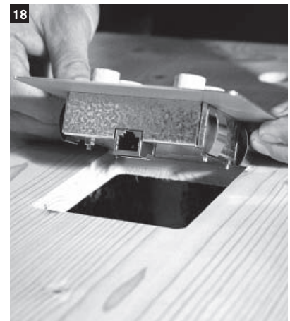
18 Vom Innenraum der Kabine nun das Steuerungsbedienteil in den vorgesehenen Ausschnitt in der Rückwand drücken.
