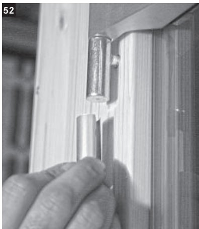
52 Die Abdeckhülsen auf die Türbeschläge schieben.
