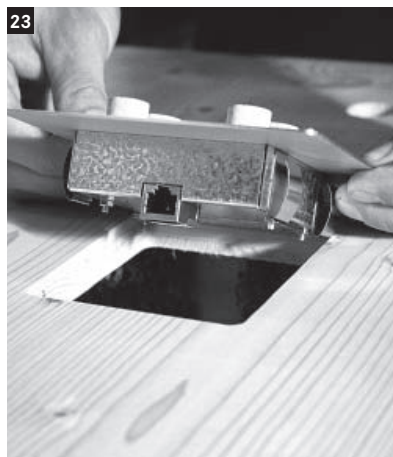
23 Das Steuerungsbedienteil in den vorgesehenen Ausschnitt drücken.
