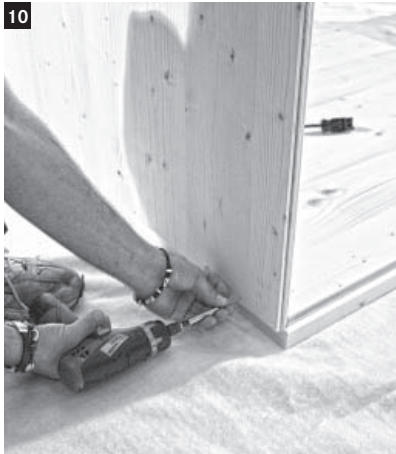
10 Die linke Seitenwand und die Rückwand auch an der Unterseite mit der Bodenplatte verschrauben.
