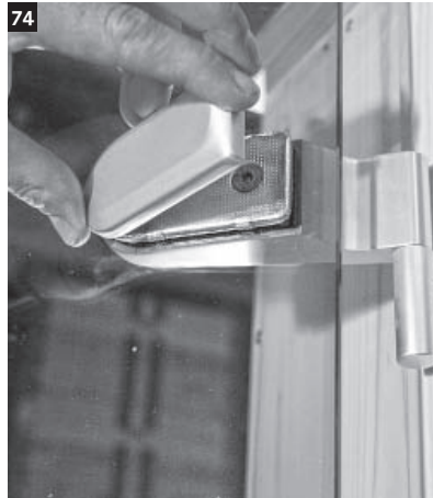
74 An der Innenseite der Tür die Verblendung auf die Beschläge drücken.
