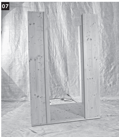
07 Die Teile der Vorderwand können kopfüber gedreht und so links oder rechts montiert werden.
