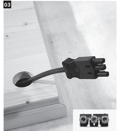
03 Die Buchse kommt durch den vorderen runden Ausschnitt. Daran wird später der Infrarotstrahler angeschlossen.
