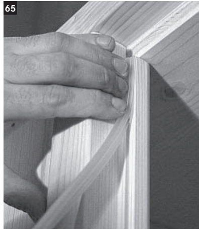
65 Die Türdichtung in die Einkerbungen beider Vorderwand-Teile drücken.
