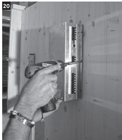
20 Das Leistungsteil auf der Rückseite der Kabine unterhalb der Innenbeleuchtung in der vertikalen Mitte anschrauben.
