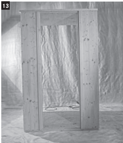
13 Nun das Deckenpaneel mit Hilfe einer zweiten Person auf die Kabine legen.
