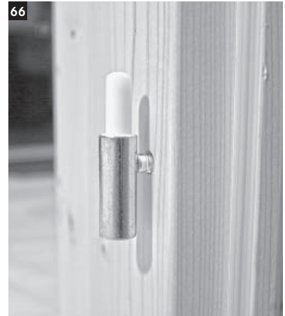
66 Die beiden Beschläge für die Angelglastür in die Vorderwand Teil 2 schrauben. Soweit, dass noch ca. zwei Gewindedrehungen zu sehen sind.
