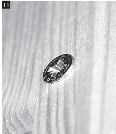
11 Alle Schrauben im Sichtbereich werden später mit Abdeckkappen abgedeckt. Daher nicht ganz in das Holz versenken!
