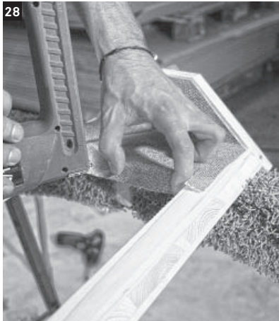
28 Die Oberseite des Strahlerausschnittes mit dem Ende der eingeschnittenen Brandschutzmatte auskleiden.
