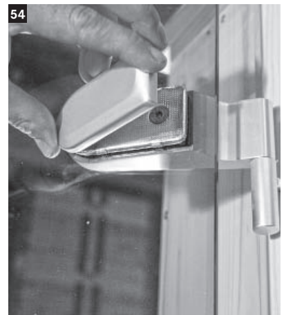
54 An der Innenseite der Tür die Verblendung auf die Beschläge drücken.
