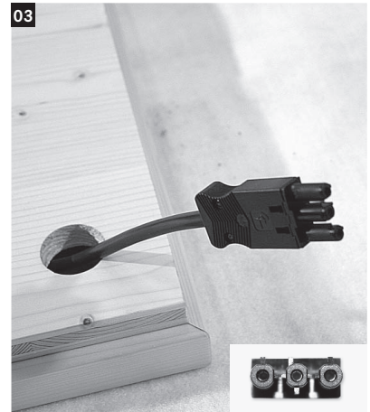
03 Die Buchsen kommen durch den vorderen runden Ausschnitt. Daran werden später die Infrarotstrahler angeschlossen.
