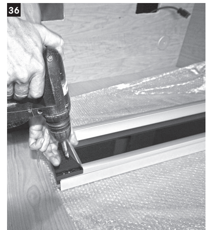
Die Tiefenwärmestrahler auspacken und für die Montage vorbereiten.
