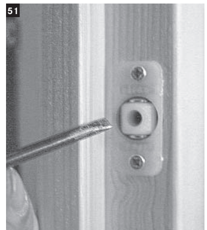
51 Die Stärke des Türschnappers kann mit dem Schrauben in der mittleren Vorrichtung justiert werden.
