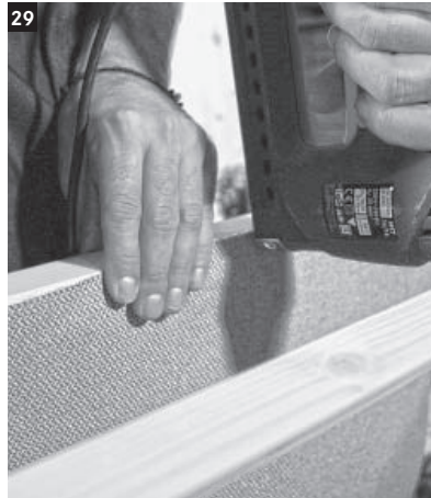
29 Die lange Seite des Strahlerausschnittes mit der großen Brandschutzmatte auskleiden.
