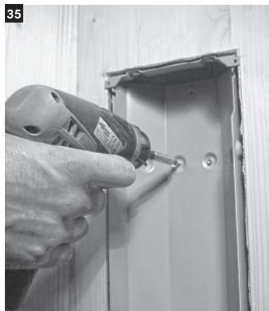
35 Durch die an der Rückwand des Einbauehäuses vorgesehenen Ausbeulungen das Strahlerpaneel an der Kabine festschrauben. Dafür die Schrauben leicht schräg einschrauben.
