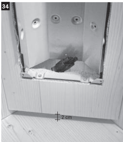
34 Das Strahlerpaneel am rechten und linken vorderen Eck der Kabine positionieren. Und zwar so, dass zur Bodenplatte ca. 2 cm Abstand sind.
