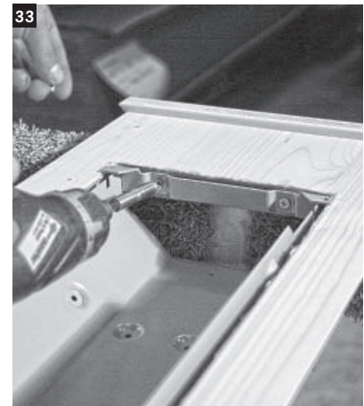
33 Das Einbauehäuse in die mit dem Brandschutz ausgekleideten Ausschnitte (Strahlerpaneelle und Rückwand) positionieren und an der Ober- und Unterseite festschrauben.
