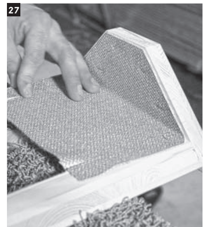
27 Dazu die passend zugeschnittene Brandschutzmatte am oberen Ende des Strahlerpaneels mit den mitgelieferten Nägeln oder einem Tacker befestigen.
