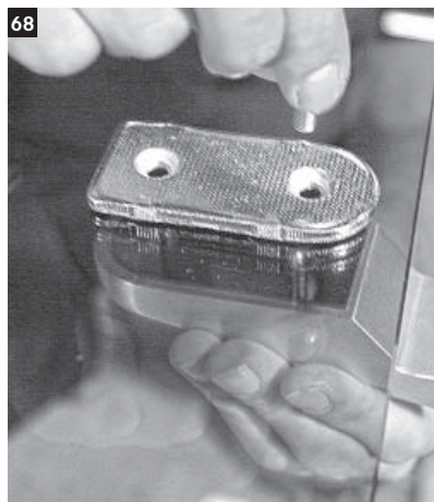
68 Nun die Beschläge mit den mitgelieferten Schrauben an der Glastür befestigen.
