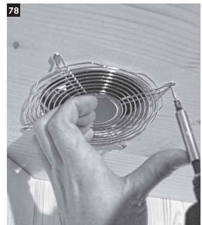
78 Im Inneren der Kabine das Lüftungsgitter über den Ausschnitt des Ventilators am Deckenpaneel befestigen.
