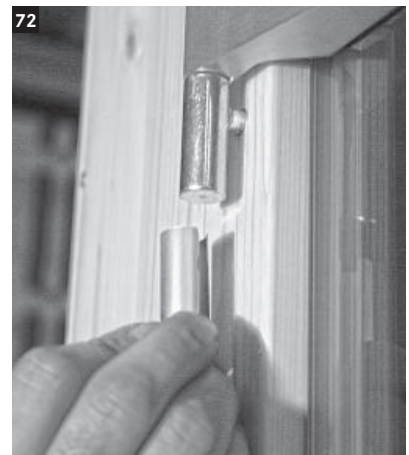
72 Die Abdekhülsen auf die Türbeschläge schieben.
