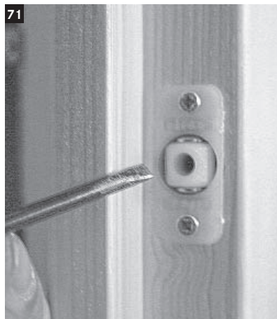
71 Die Stärke des Türschnappers kann mit dem Schrauben in der mittleren Vorrichtung justiert werden.
