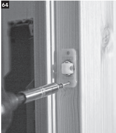
64 Für die Montage der Tür den Türschnapper in die Vorbohrung in der Vorderwand Teil 1 geben und festschrauben.
