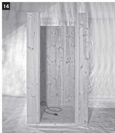
14 Die Teile der Vorderwand können kopfüber gedreht werden und so links oder rechts montiert werden.
