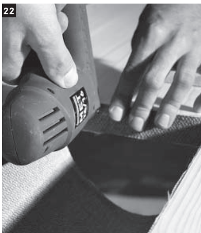
22 Die kurzen Brandschutzbänder an den kurzen Seiten der Leibung anbringen.
