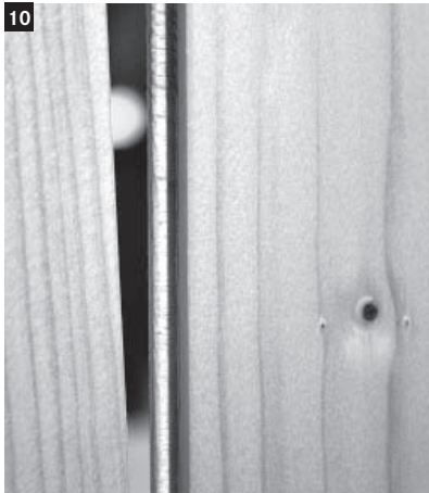
10 Die Feder muss immer in die vorgegebene Nut gesetzt werden.
