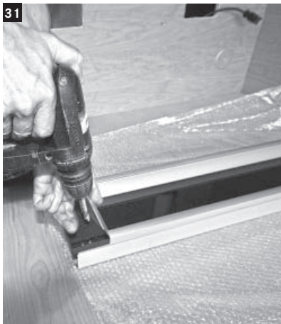
31 Die Tiefenwärmestrahler auspacken und für die Montage vorbereiten.
