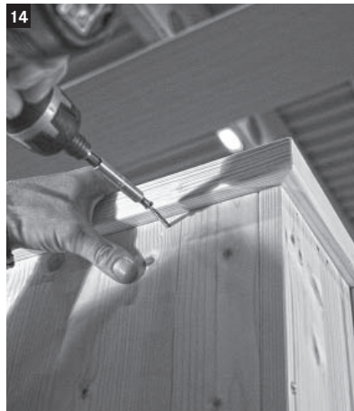
14 Das Deckenpaneel mit den Seitenwänden an den vorgebohrten Stellen verschrauben.
