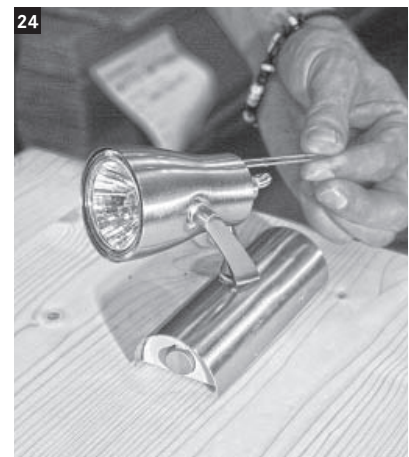
24 Die Innenbeleuchtung montieren. Die Elektroanschlussarbeiten von einem autorisierten Elektrounternehmen vornehmen lassen. Dazu wird die Anschlussleitung mit Stecker und freiem Ende (100 cm) benötigt.
