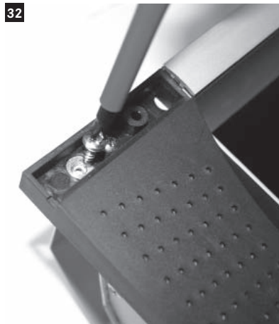
32 Dafür die äußersten Schrauben an den Ecken des Strahlers heraus-schrauben und den Strahler vorsichtig vom Einbauehäuse lösen.
