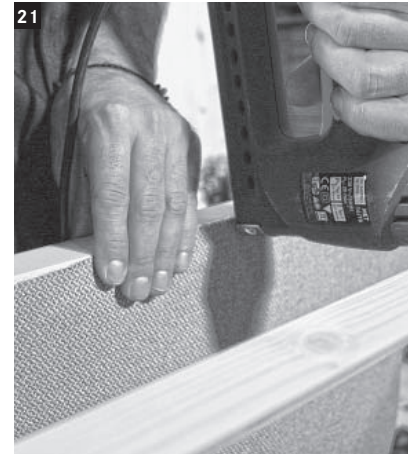
21 Der Brandschutz kann auch mit einem Tacker angebracht werden.
