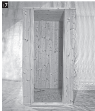
17 Nun das Deckenpaneel mit Hilfe einer zweiten Person auf die Kabine legen.
