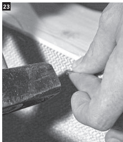
23 Die Strahlerausschnitte in der Rückwand mit dem Brandschutz versehen. Dafür wird an den Leibungen, in die später die Strahler montiert werden, längsseitig die Brandschutzmatte mit Hilfe der mitgelieferten Nägel ausgekleidet.
